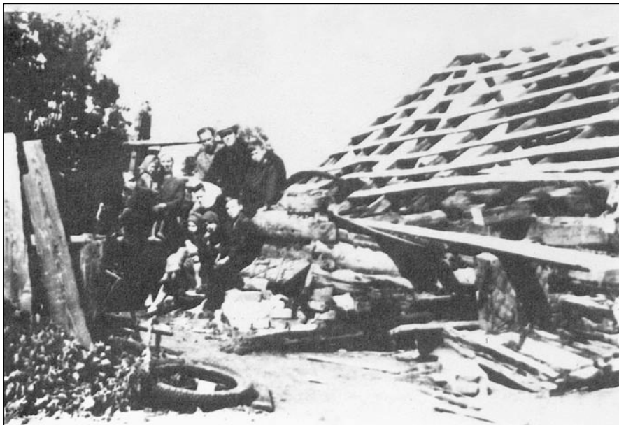
Семья Н. Я. Дейнеги у дома, разрушенного трактором.
